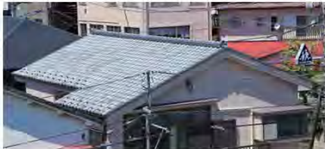
健全な瓦屋根
