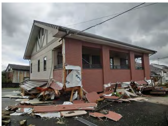
写真6 倒壊した木造住宅
