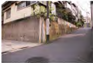
擁壁や坂 に面する
