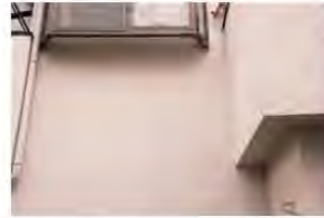
健全な外壁（ひび割れ等がない）
