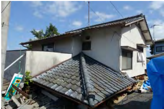
写真2 倒壊した木造住宅
