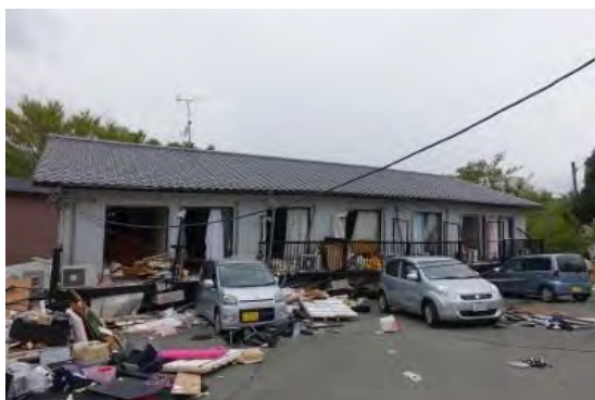
写真 12 倒壊した木造アパート
