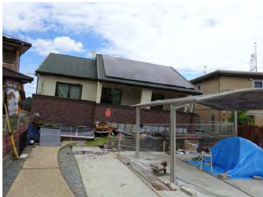
写真4 倒壊した木造住宅
