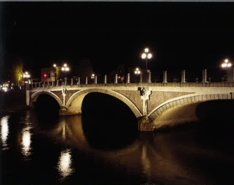
第25回いしかわ景観賞 浅野川歴史的橋梁照明整備
