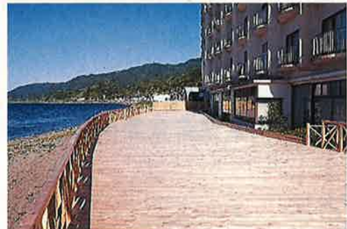
ホテルこうしゅうえん天海シーサイドテラス【輪島市】(設計・施工:山下住宅)
