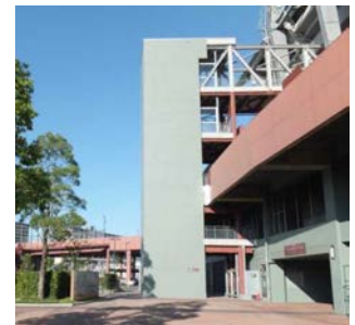
D 大型エレベーター 利用者アンケートに基づき、3階のコンコース・観覧席に至るエレベーター(26人乗 高齢者・障害者優先)を2014年に増築した。
