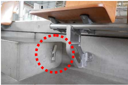
・観覧席の下部に設けられた補聴器用アンテナ線の差し込み口
