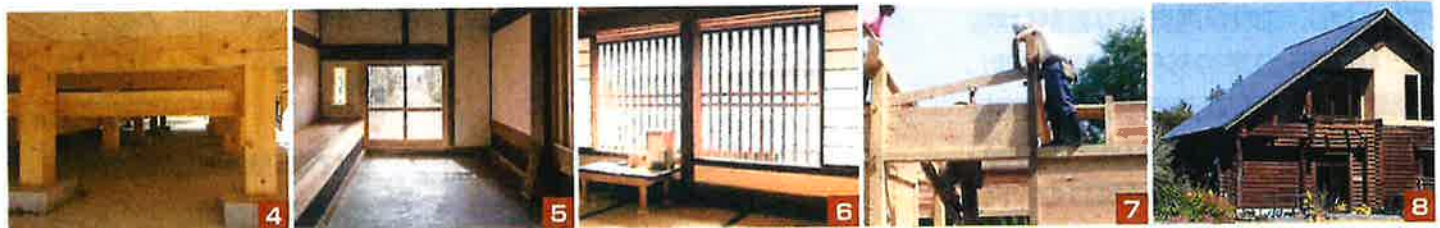
石場建てによる開放的な床下
