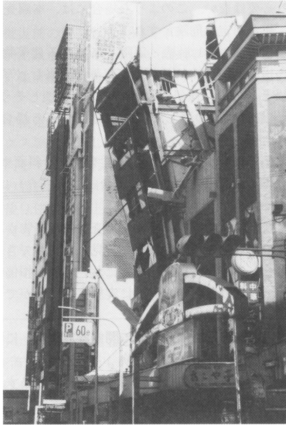
写真-4 著しく傾斜した建築物
