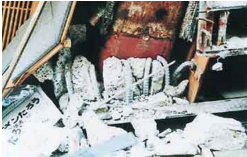
写真-20 根巻きコンクリートの高さが十分でない根巻き柱脚の移動
