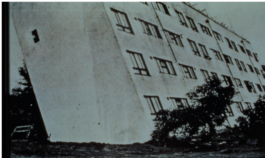
図-6 全体沈下と全体傾斜の被害例
