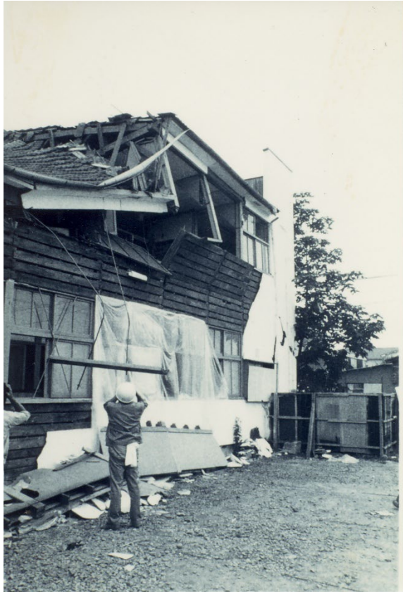
写真-7 建築物の不同沈下(Cランク)
