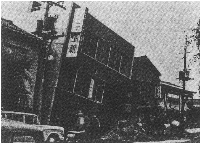
図-8 全体沈下が1mを超える被害例
