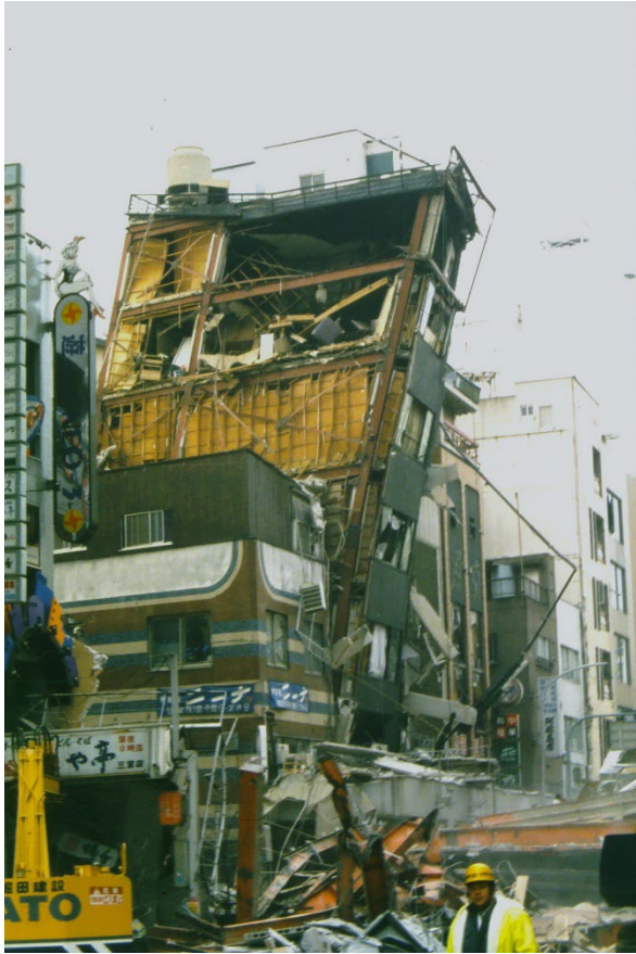
写真-11 傾斜が生じた建築物
