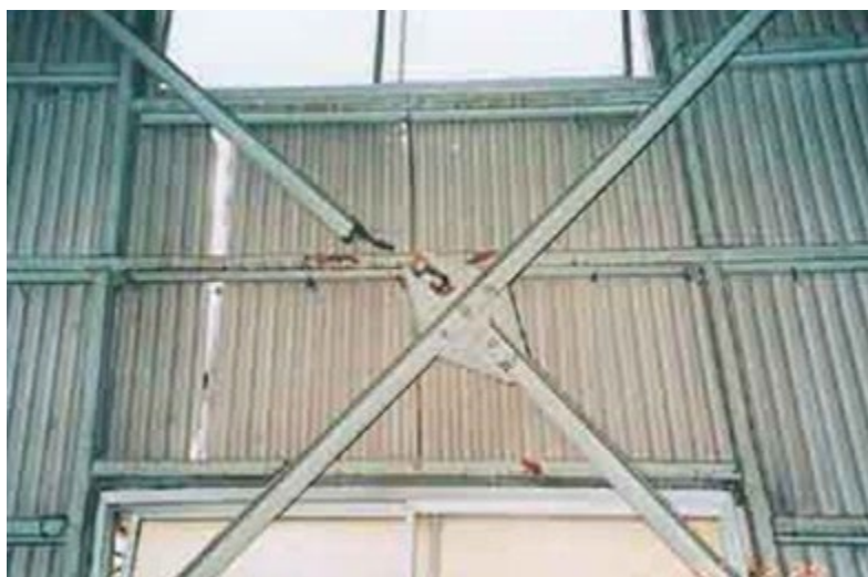
写真-16 アングル（山形鋼）筋かいの破断
