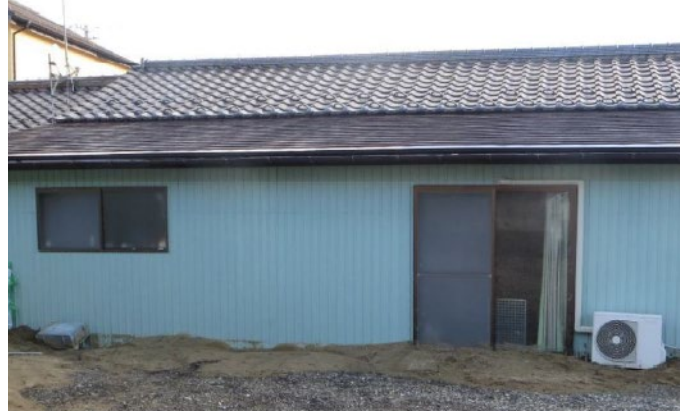
写真-3 建物が傾斜しているが、傾斜は全体的で基礎の一体性が保たれている（Bランク）
