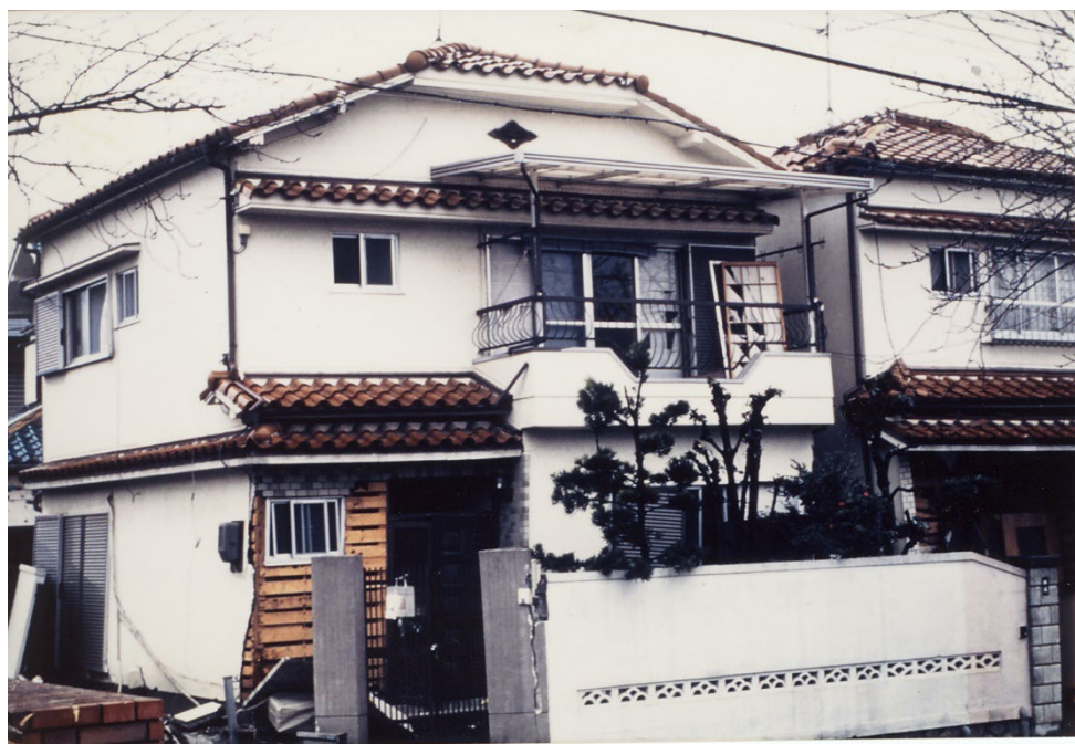
写真-11 壁の被害(外壁)(Bランク)
