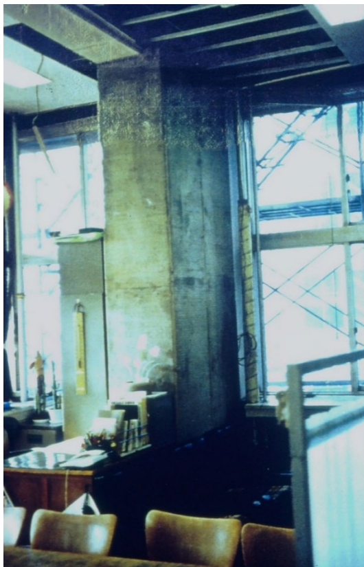
写真1 大破した鉄筋コンクリート造柱に添わせて十分大きな鉄筋コンクリート造柱を増設した応急補強の例
