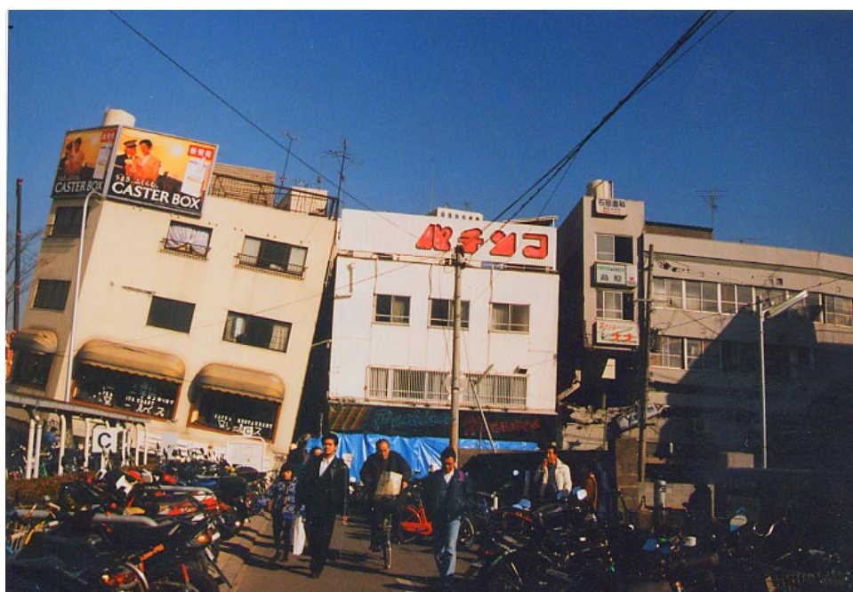
図－5 隣接する建築物（写真左）の被害により、当該建築物に危険が及んだ例
