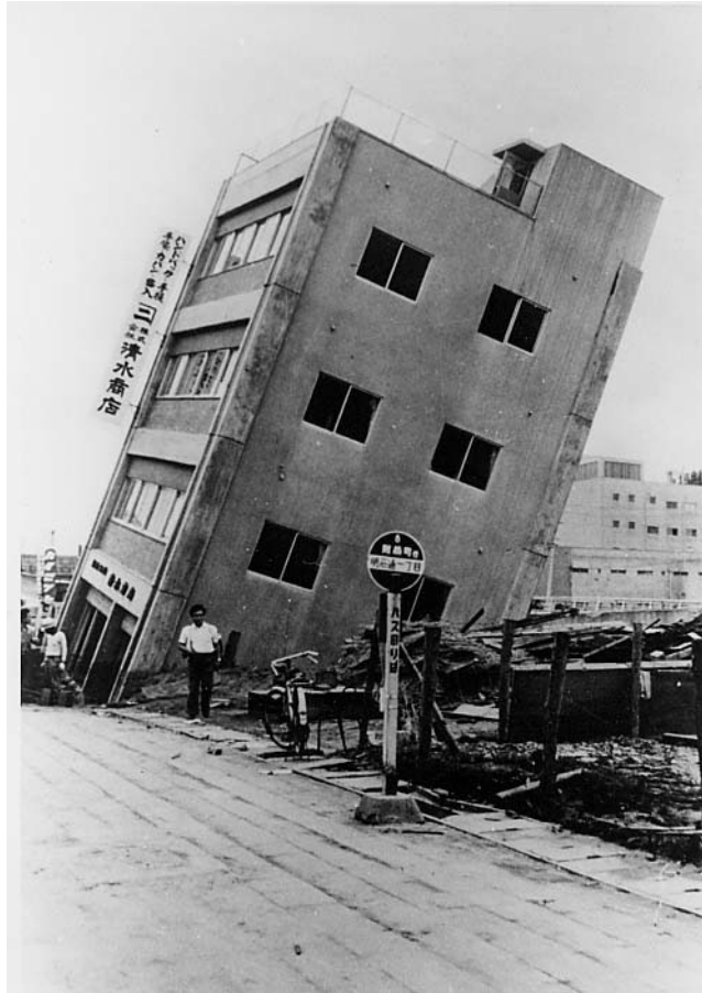
図-7 建築物の全体傾斜が2度以上の被害例
