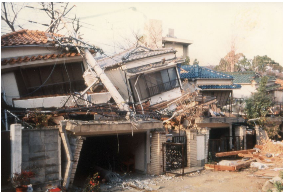
写真-1 一見して危険と判断される
