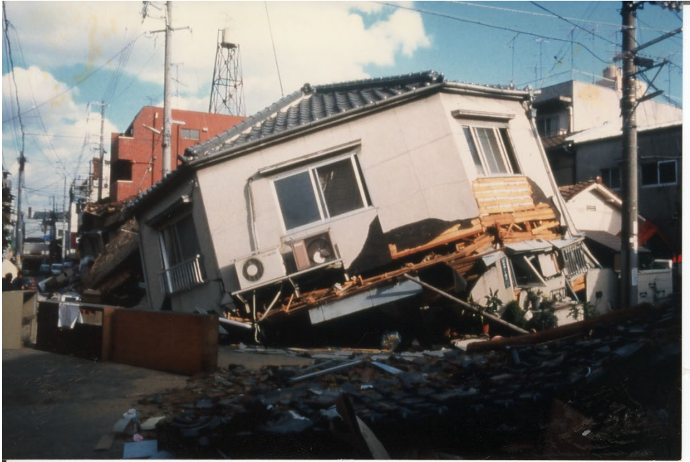
写真-2 一見して危険と判断される
