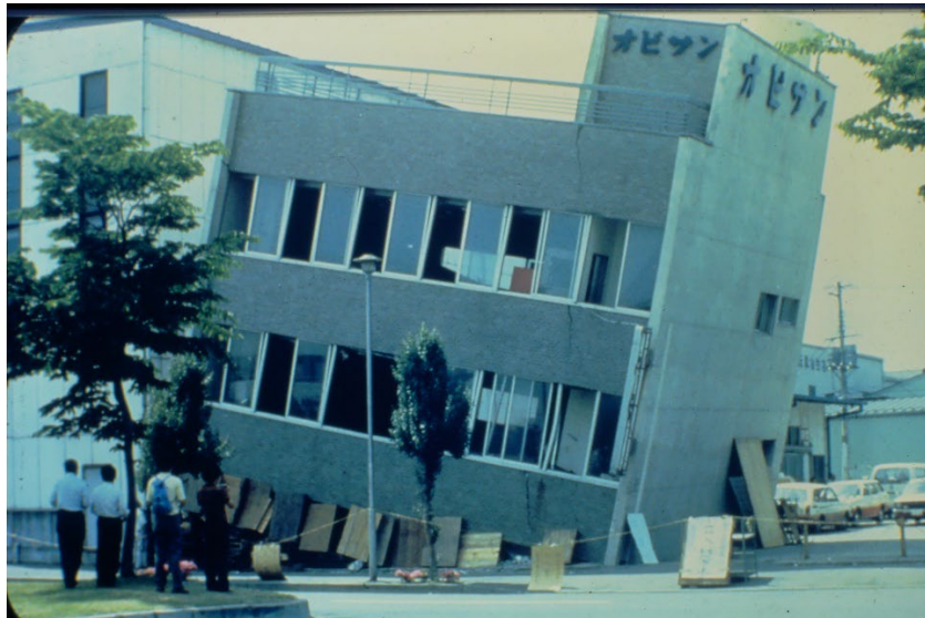
(b) 1階柱の破壊による部分傾斜の被害例
