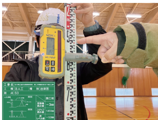
工事中における床レベルの確認
