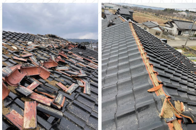
地震間もないころの屋根応急作業の際に撮った写真
