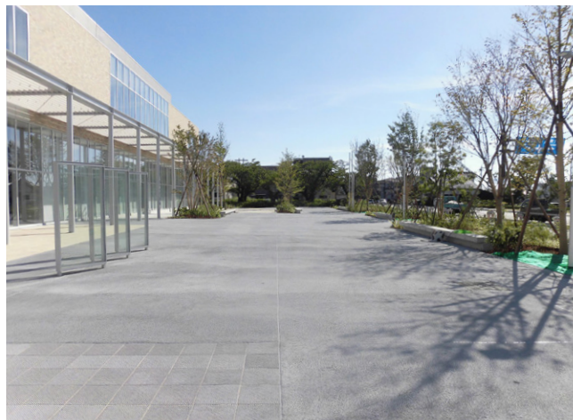
2号館前広場(地下に雨水貯留槽を整備)
