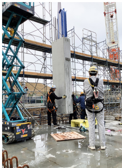
PCa柱建方状況
