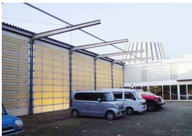
たかとり教会 可動庇(オーバースライダー)
