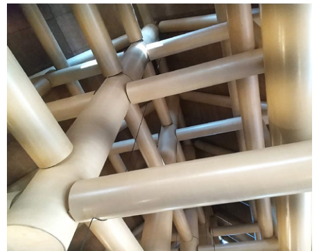
陽・燦燦 小屋組の様子
