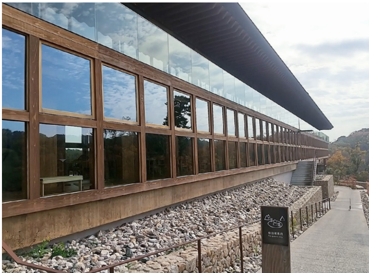
禅坊靖寧 窓の格子も構造体
