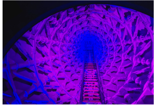
太陽の塔 腕部の鉄骨造
