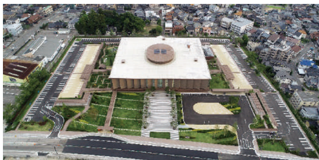
敷地全景（前面道路側上空から望む）
