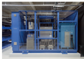
水素貯蔵装置
