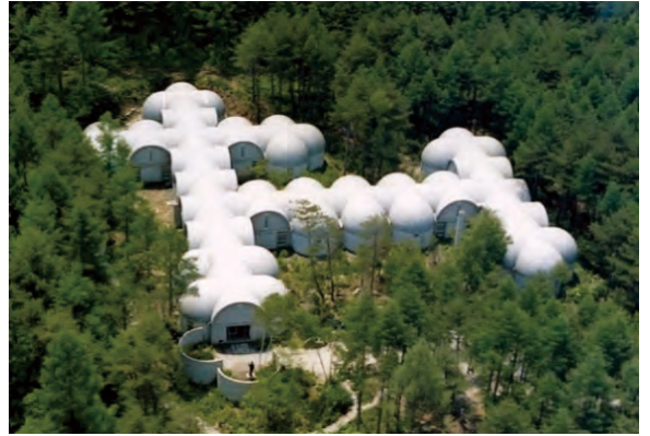
建設当時の上空写真
